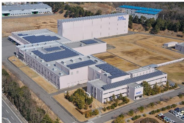
ファンケル美健 滋賀工場の太陽光パネル
