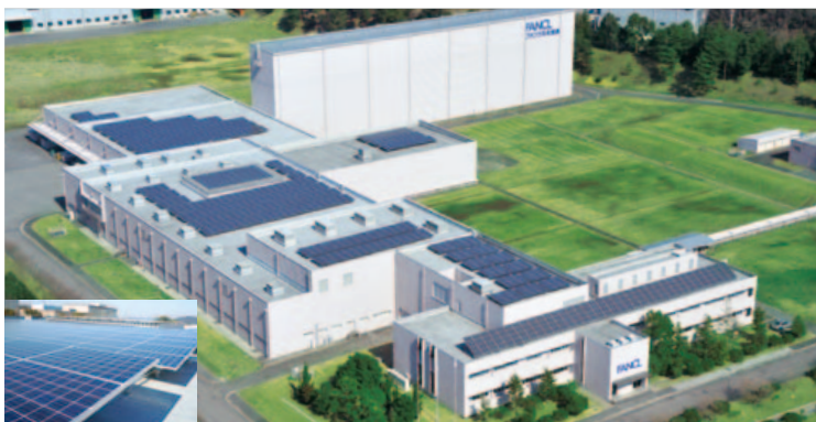
滋賀工場の太陽光発電システム
